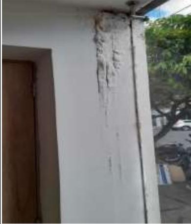
Cableado eléctrico expuesto y ausencia de tapa protectora en conexiones eléctricas.
